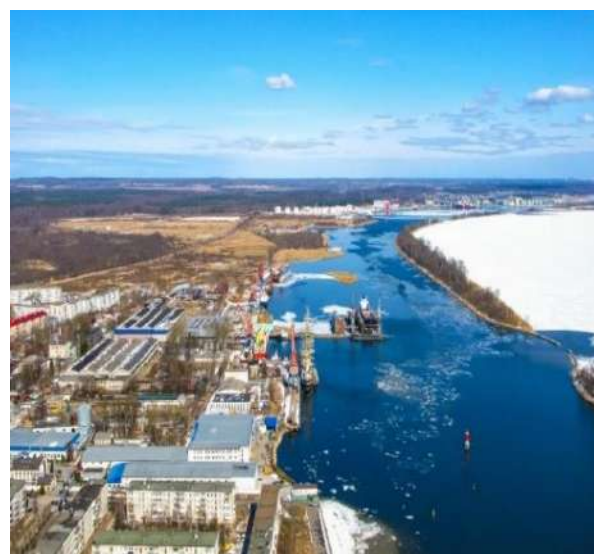
Рис.13.27. Правдинская ГЭС-3 на реке Лава
