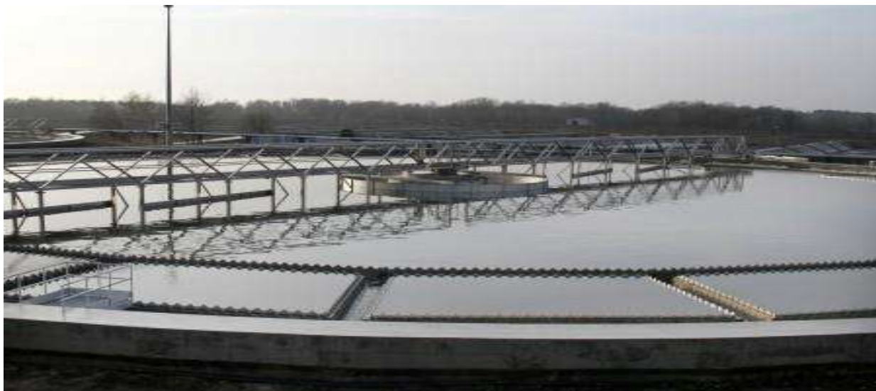
Рис.3.26. Очистные сооружения в городе Гвардейске
