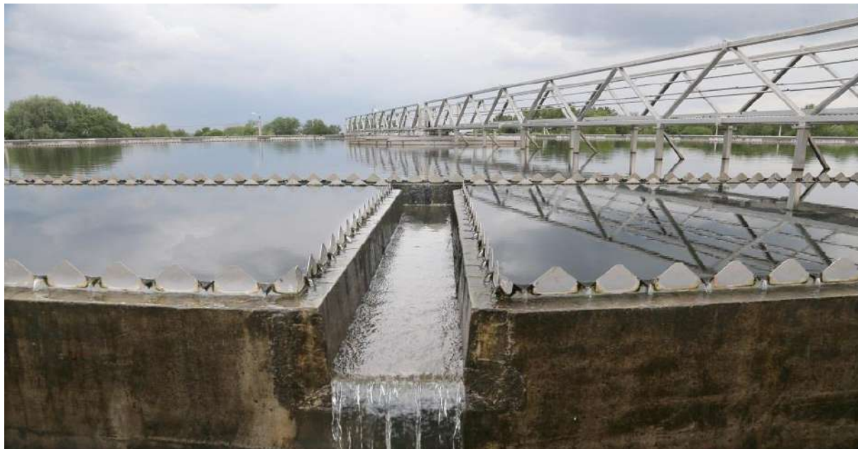
Рис.3.24. Очистные сооружения г. Калининград
