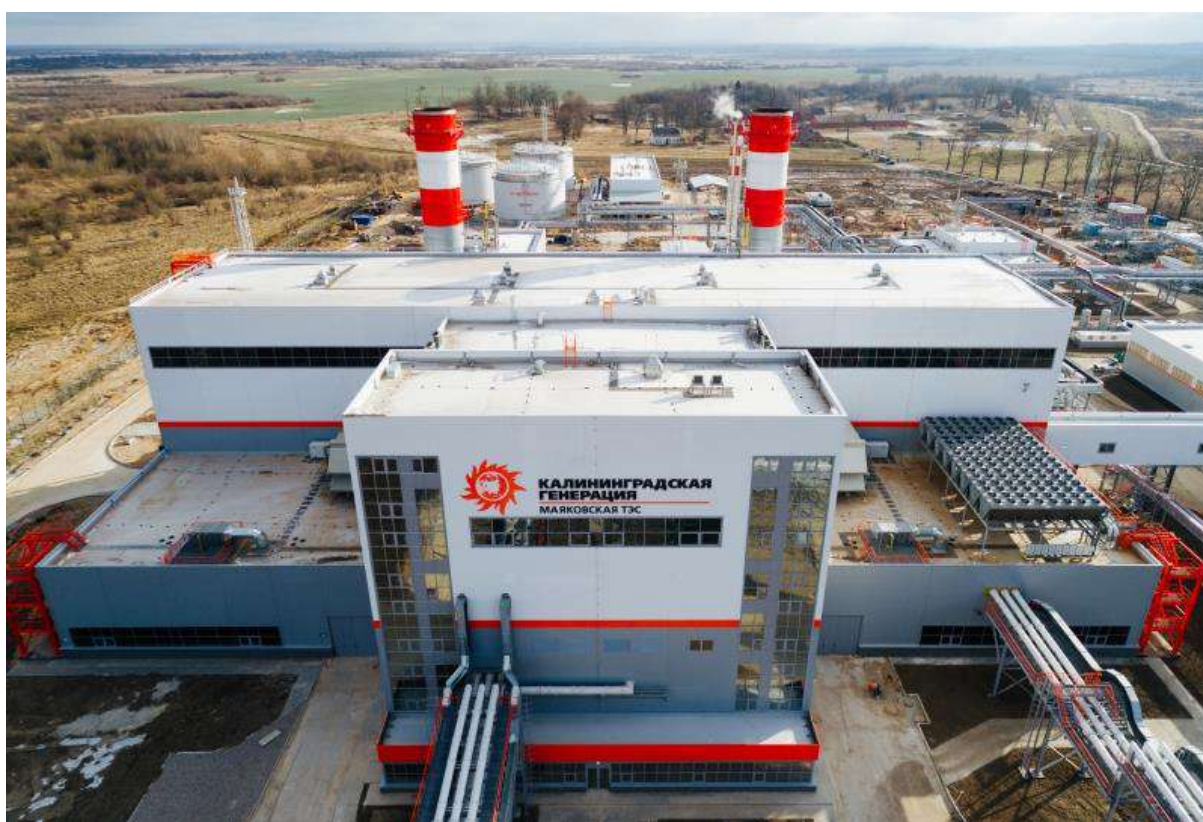
Рис. 1.5. Маяковская тепловая электростанция, г. Гусев
