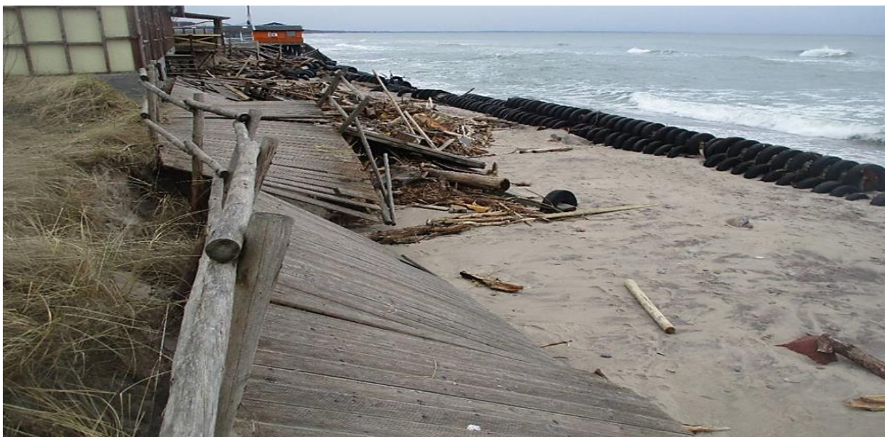
Рис. 3.10. Последствия шторма в январе 2019 г. в районе свайно-ячеистой бермы в пос. Лесной
