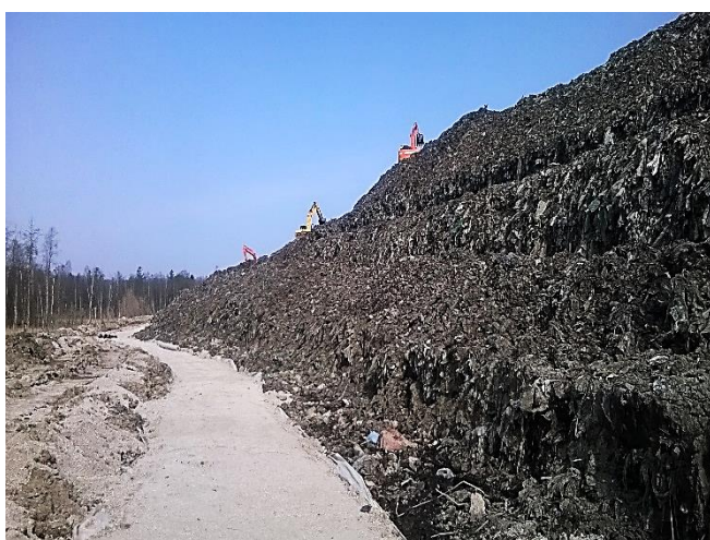
Рис. 4.3. Склон полигона во время работ по рекультивации
