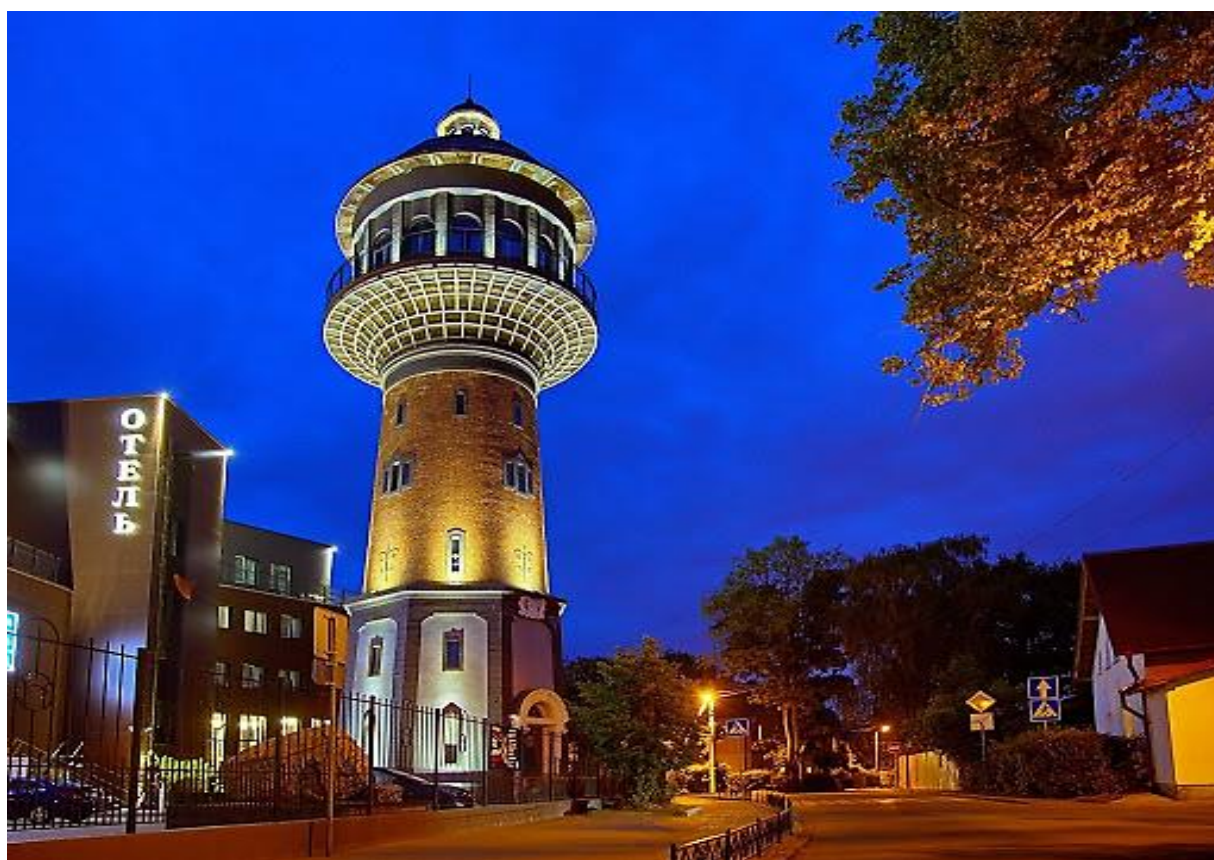
Рис. 13.7. Водонапорная башня в г. Зеленоградске
