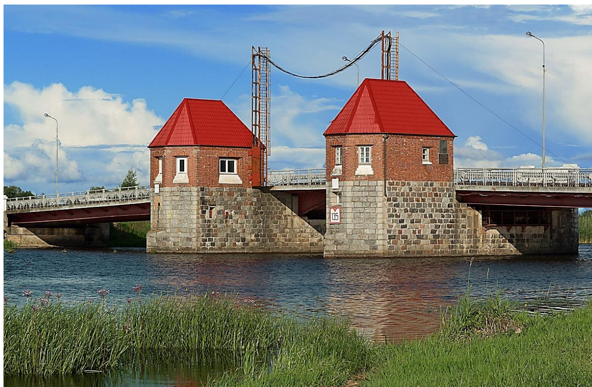
Рис. 13.15. Мост через р. Писса в г. Полесске
