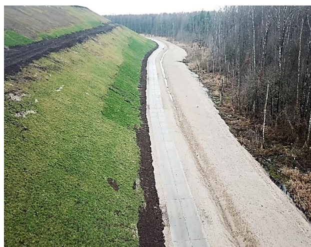
Рис. 4.4. Склон полигона после проведения работ по рекультивации
