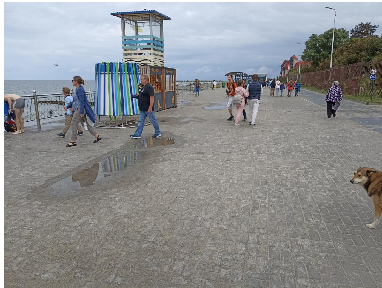
Тротуарная плитка из-за разрушения не в состоянии отвечать возложенным на нее функциям
