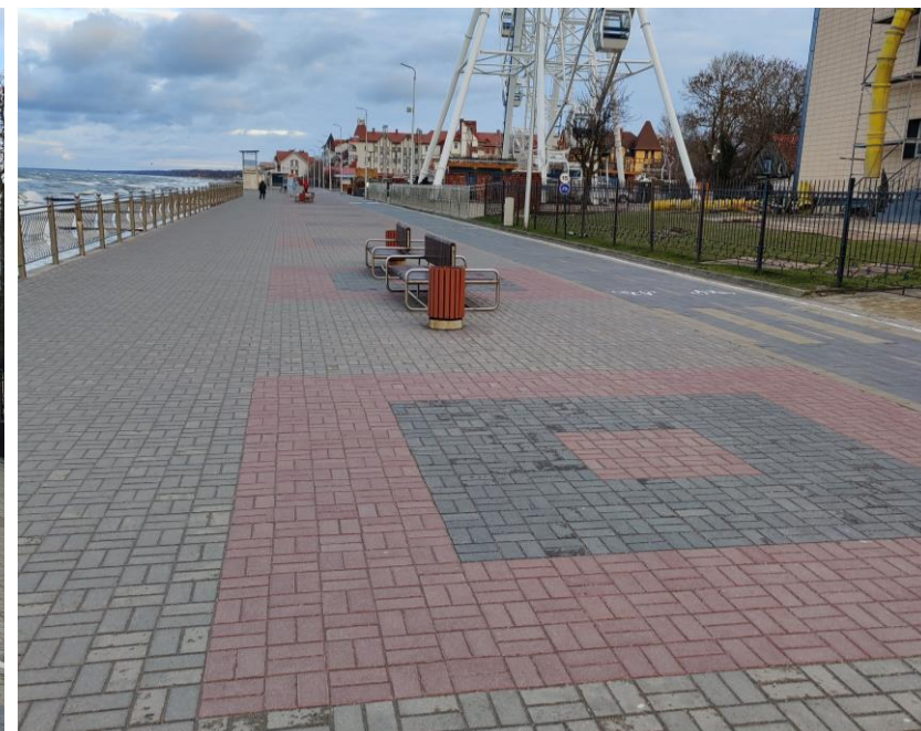
Отсутствие озеленения променада
